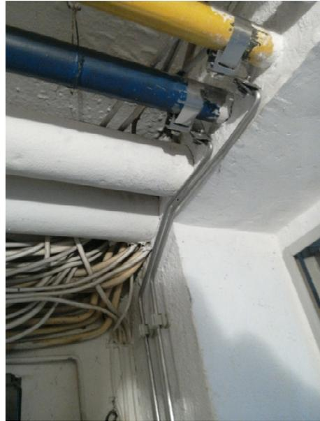
Bild 2: Wasser und Gas an Potenzialausgleich angeschlossen, Heizung nicht an Potenzialausgleich angeschlossen
