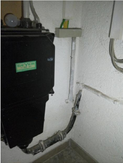
Bild 1: Potenzialausgleichschiene mit Verbindung zum Erdungssystem
