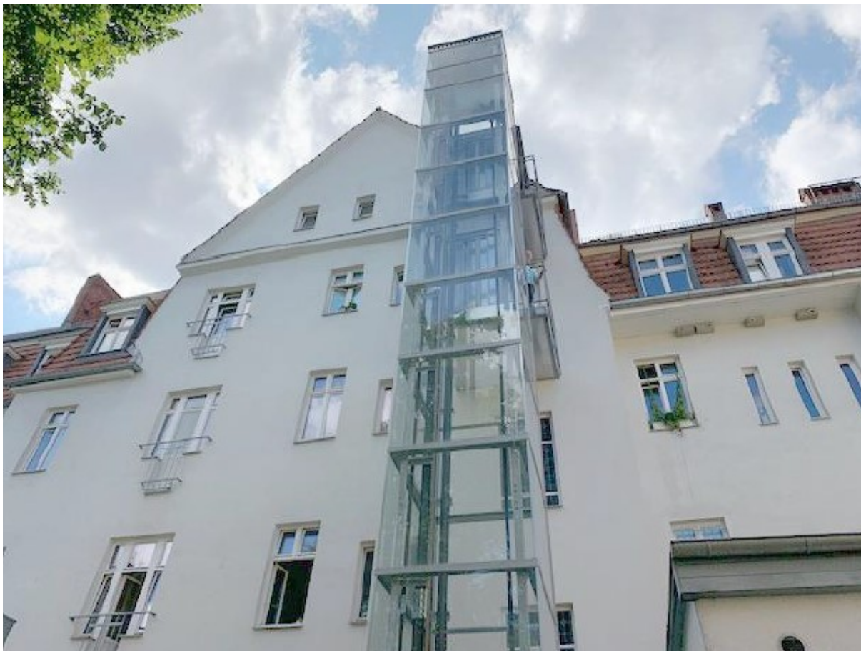
Abb. 79: Innenhof mit Aufzug
