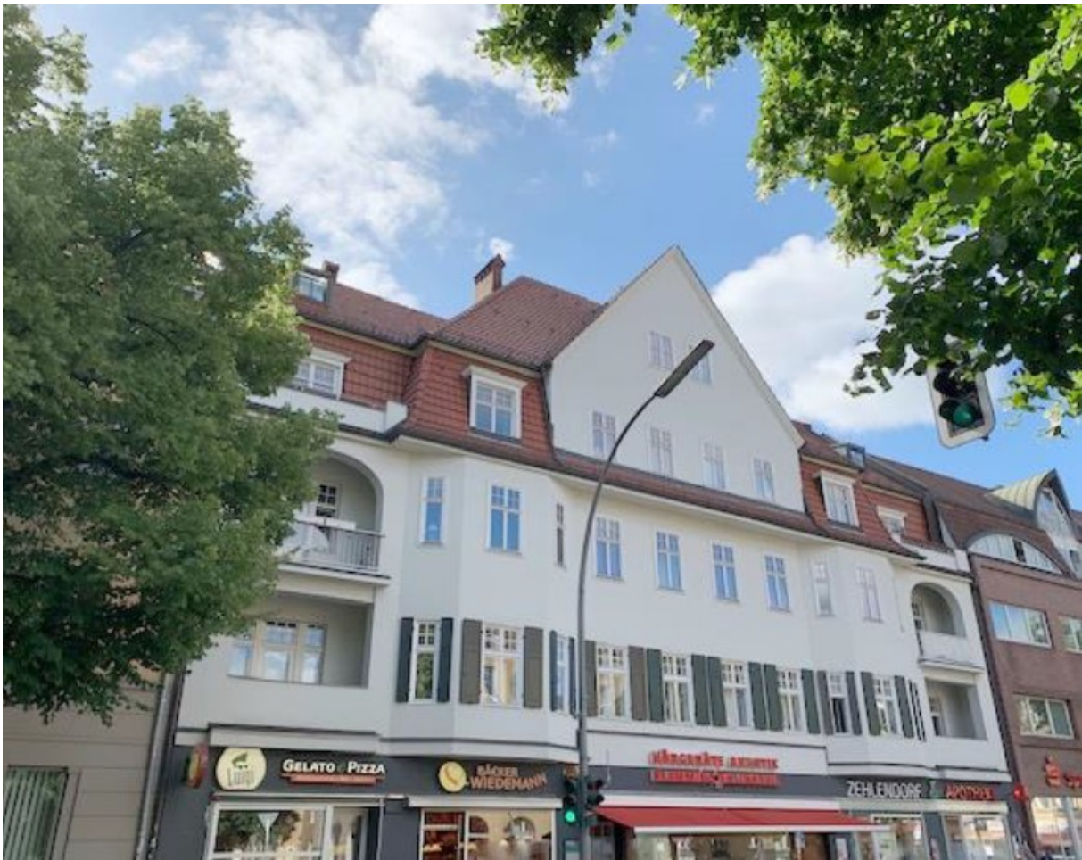
Abb. 77: Wohn- und Geschäftshaus Berlin Zehlendorf Außenansicht
